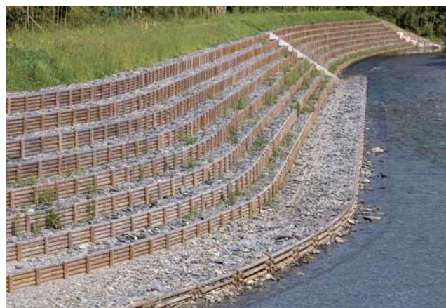
木と石による護岸は人と環境にやさしい景観を生み出す。
